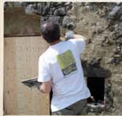
Reprise de façade avec un enduit à la chaux
