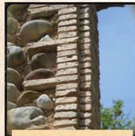
Un encadrement de fenêtres en briques pleines présentant une encoche formant la feuillure.
