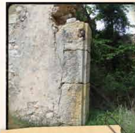
Un jambage de porte en pierre de taille calcaire entaillée d'une feuillure.
