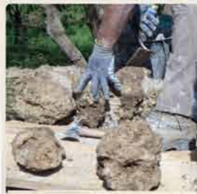
Restauration d'une voûte en pierres
