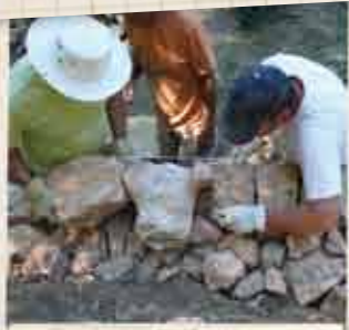
Restauration d'un mur en pierre sèche
