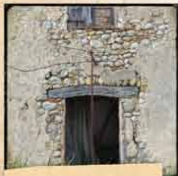
Un encadrement avec galets hourdés au mortier de chaux.
