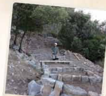
Pose des conducteurs d'une calade
