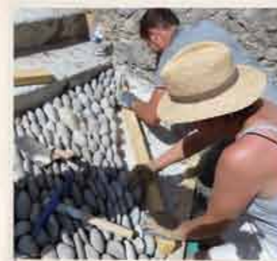
Remplissage d'une calade avec des galets
